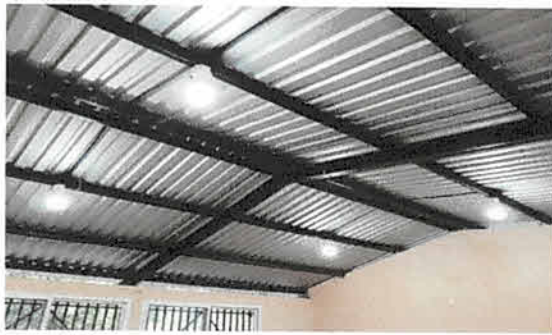
suministro de sistema electrico
