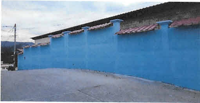
Suministro de muro perimetral
